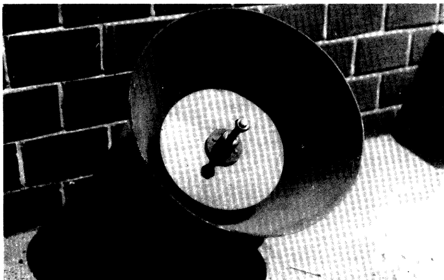
21. ábra KOP-F típusú léglökésvédő szelep
